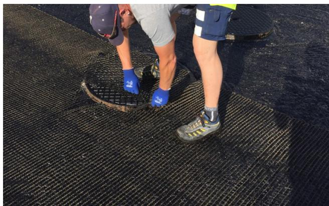
As grelhas podem ser facilmente cortadas à volta das câmaras de visita
