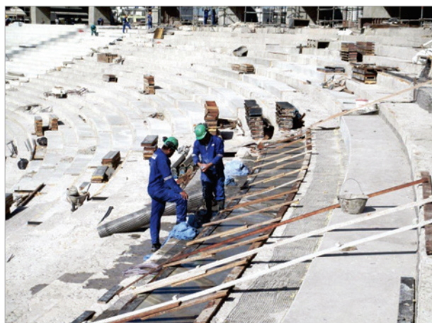
Figura 10 – Aplicação de malha de carbono em bancadas/ pormenor do reforço
