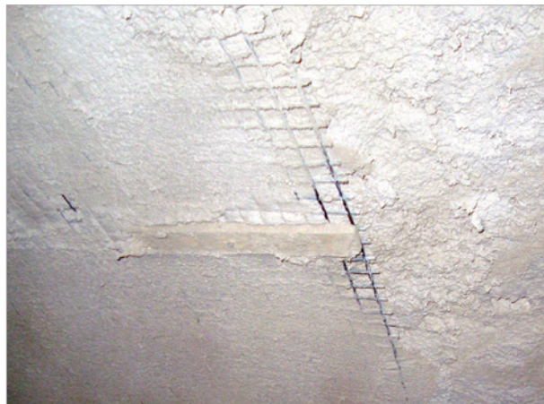
Figura 11 – Aplicação de malha de carbono no intradorso da abóboda
