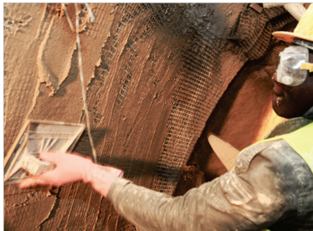
Figura 11 – Aplicação de malha de carbono no intradorso da abóboda
