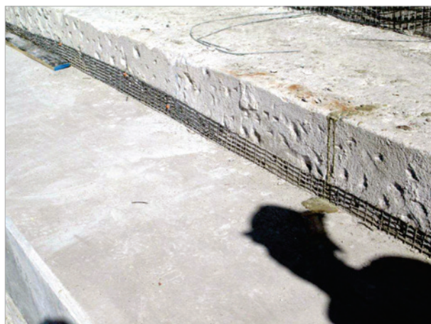
Figura 10 – Aplicação de malha de carbono em bancadas/ pormenor do reforço
