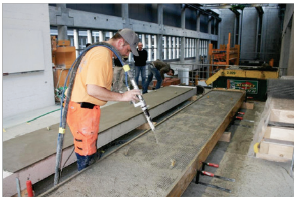
Figura 7 – Aplicação da argamassa como matriz
