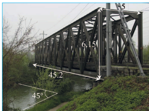
[b] Constituição de 10 painéis com comprimento total de 45.2 m, altura de 6.5 m e largura de 5 m, em construção enviesada a 45°
