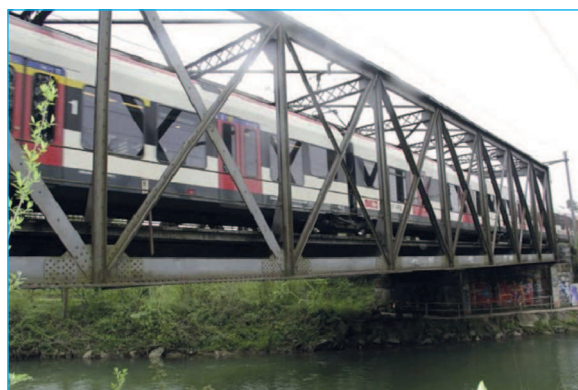
[a] Ponte sujeita à ação de Comboio S3
