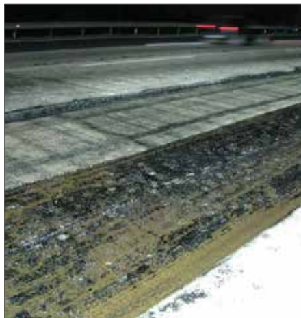
▲ Grelha de reforço da S&P colocada sobre a emulsão asfáltica de aderência.
